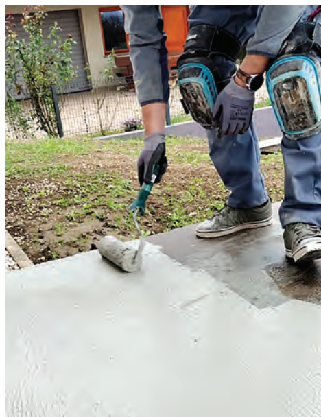
Ugradnja prvog sloja hidroizolacije MAPELASTIC TURBO ZERO
