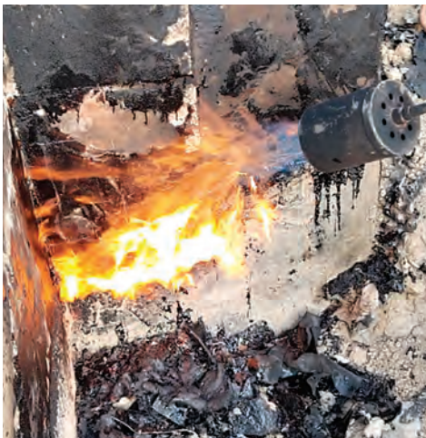
Uklanjanje stare bitumenske hidroizolacije plamenikom
