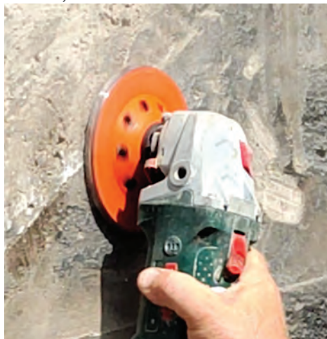
Brušenje podloge do zdravih dijelova radi bolje prionjivosti nove hidroizolacije
