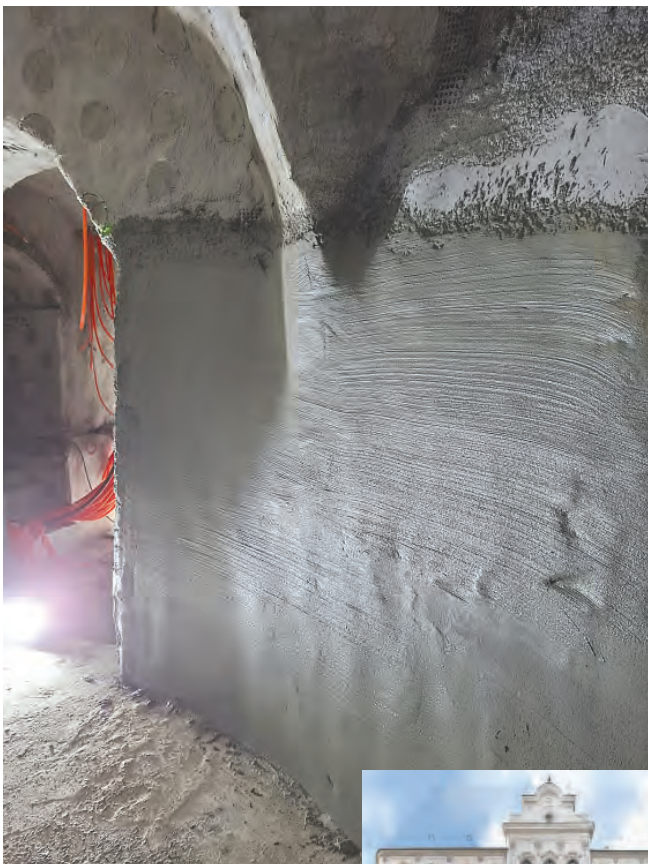
Sanacija palače VOKR; manja fotografija - izvor: www.hrz.hr
