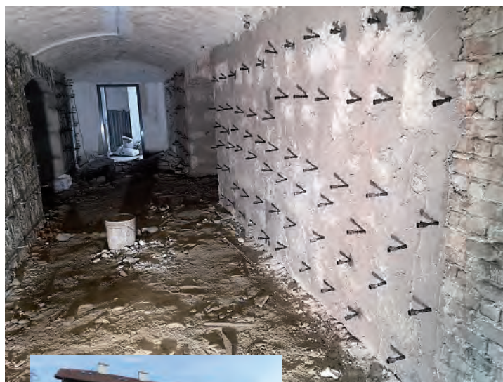
Postupak injektiranja u muzeju u Svetom Ivanu Zelini
