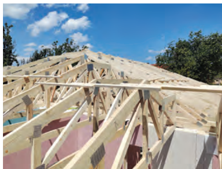
Postavljanje krovne konstrukcije kosog krova, izvor: Uredništvo
