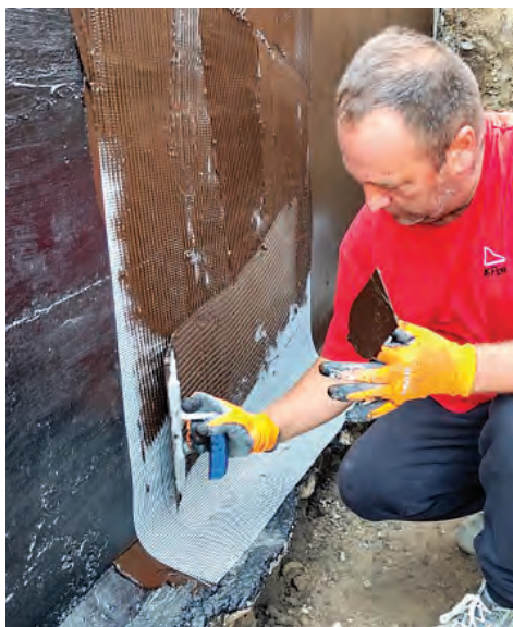
Ugradnja staklene mrežice u svježi prvi sloj paste
