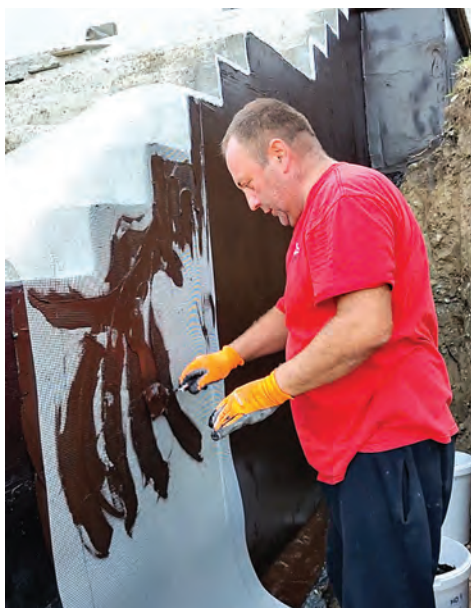
Utapanje mrežice u prvi sloj bitumenske hidroizolacije
