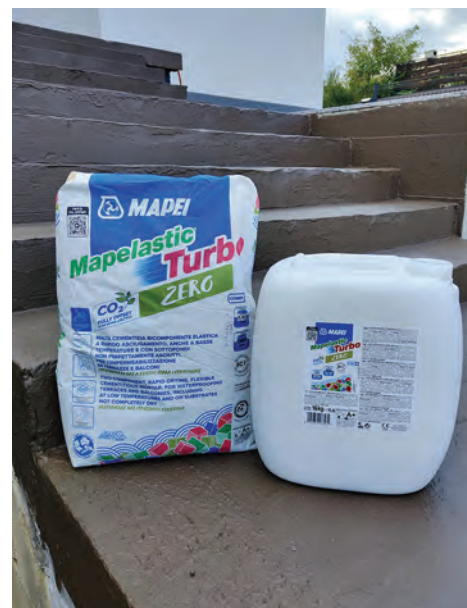
Stepenice presvučene s dva sloja hidroizolacije
