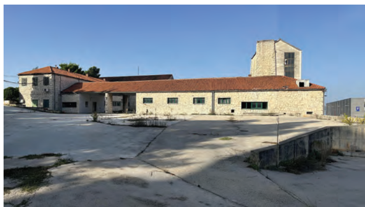
Slika 02. Pogled na istočno krilo kompleksa vinarije Vinoplod u Šibeniku, stanje 2025. (fotografija Antonio Vudrag)
