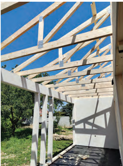
Postavljanje krovne konstrukcije kosog krova, izvor: Uredništvo
