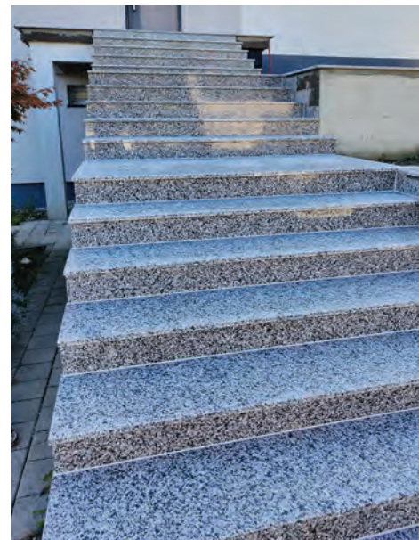
Završni izgled obnovljenih stepenica
