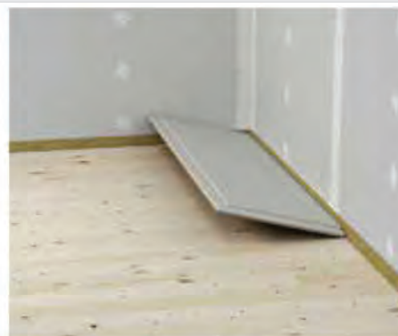
3 Polaganje estrih elementa fermacell®
