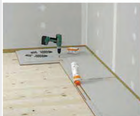
4 Nanošenje ljepila za estrih fermacell™ na područje utora
