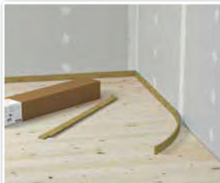
1 Polaganje rubne izolacijske trake i usko spajanje u kutove
