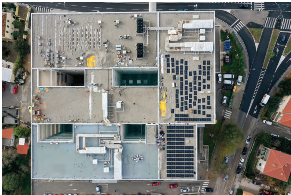
Slika 7: Krov tijekom izvođenja radova i dio s izvedenom hidroizolacijom.
