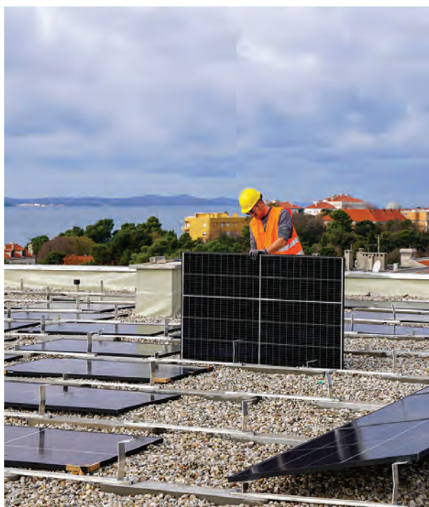
Slika 8: Postavljanje solarnih panela.
