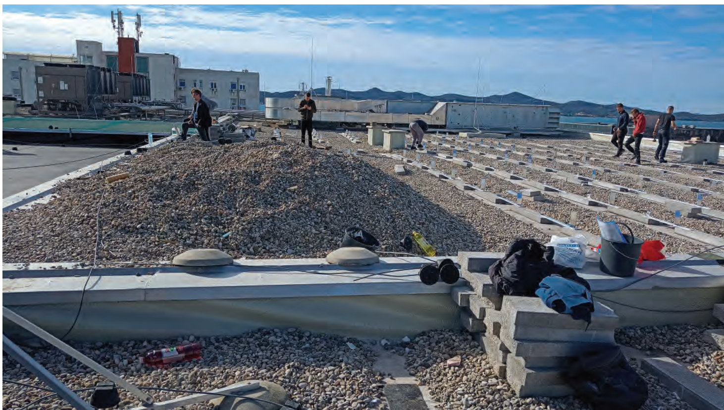
SLIKA 6: Nakon provjere vodonepropusnosti balast je vraćen.
