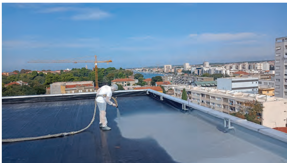
Slika 5: Nosivi sloj hibridne poliuree PURTOP 500 N nanesen je strojno 30 minuta nakon sazrijevanja temeljnog premaza pri temperaturi materijala između +65°C i +85°C i tlaku 160 – 200 bara.
