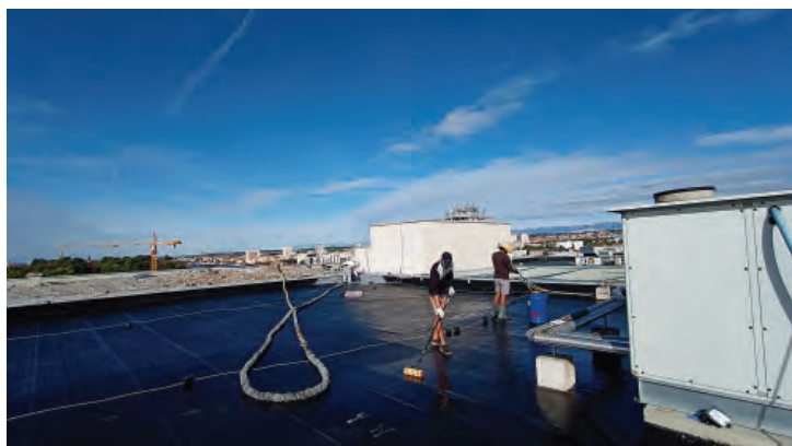
Slika 3 i 4: Nanošenje PRIMER-a P2, niskoviskoznog promotora prionjivosti na bazi otapala koji je na prethodno pripremljenu podlogu nanesen valjkom.
