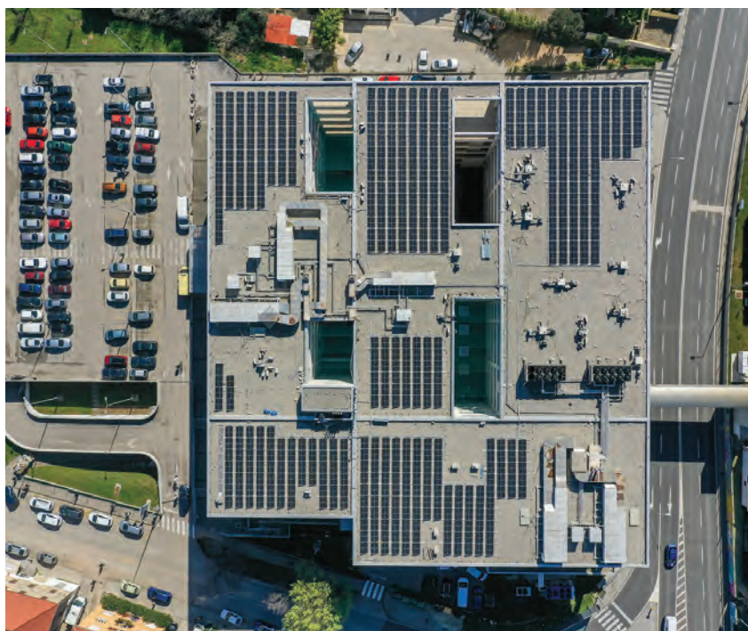
Slika 9: Završni izgled krova.
